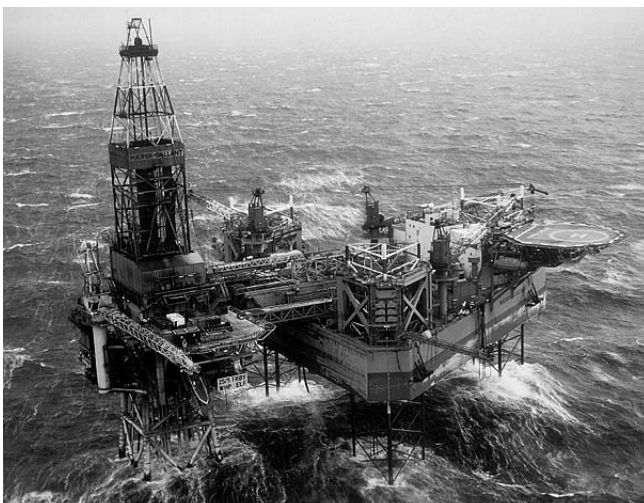
Figuur 3 Een jackup bezig met een onderhoudsoperatie aan een productieplatform.
