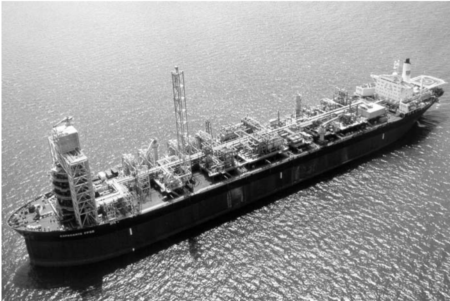
Figuur 2 Een tot FPSO omgebouwde supertanker met de turret waarom heen het schip vrij kan draaien duidelijk zichtbaar op het voordek. De proces modules staan op de dek.
