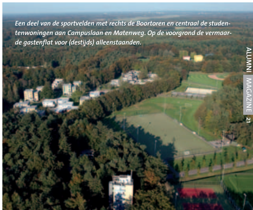
Halfverscholen in het bos: het Sportcentrum dat voor de zomer 2005 volledig wordt gerenoveerd. Links onder is nog net de Boortoren zichtbaar, het clubhuis van hockeyvereniging Drienerlo.
