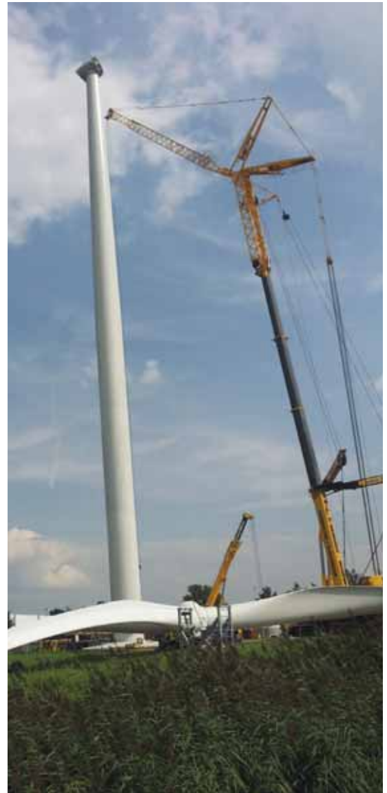
Breda Duursaam-Energiecoöperatie BRES: Windpark Hazeldonk in aanbouw (aug. 2015)
