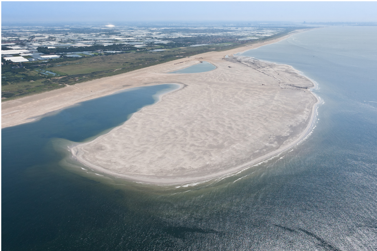
Figure 2.1 – Sand Engine Delfland ( https://beeldbank.rws.nl , Rijkswaterstaat / Joop van Houdt)
