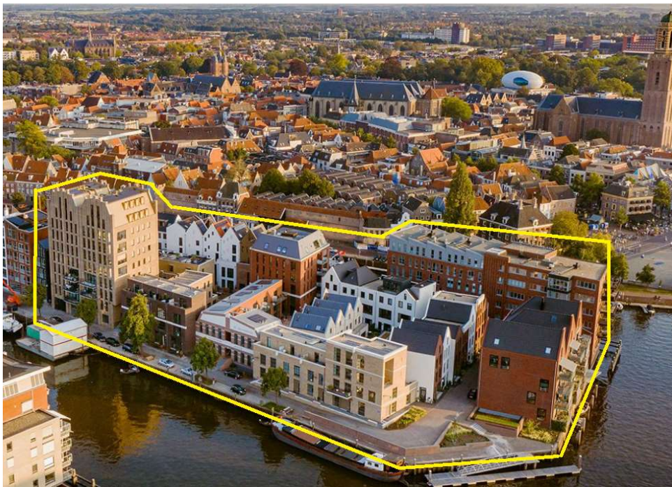
Figure 9: Overview finished project Kraanbolwerk (VanWonen, n.d.)
