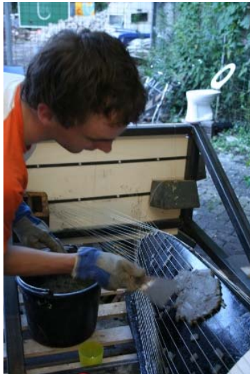
Figuur 14 – Aanbrengen van het beton
