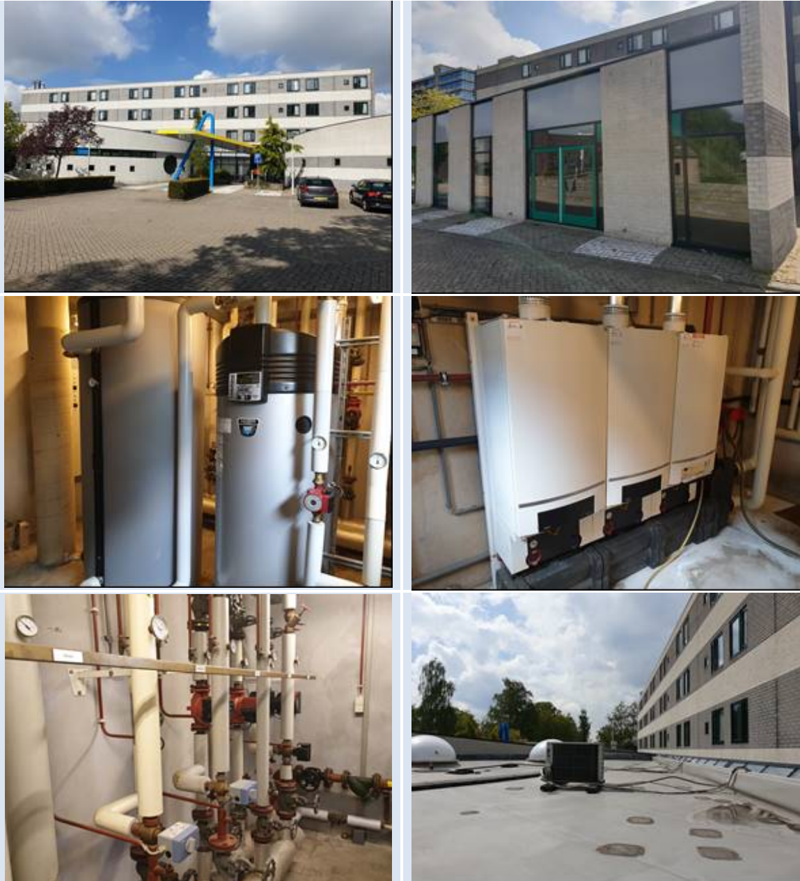
Figuur 2.1 Foto's gebouw
