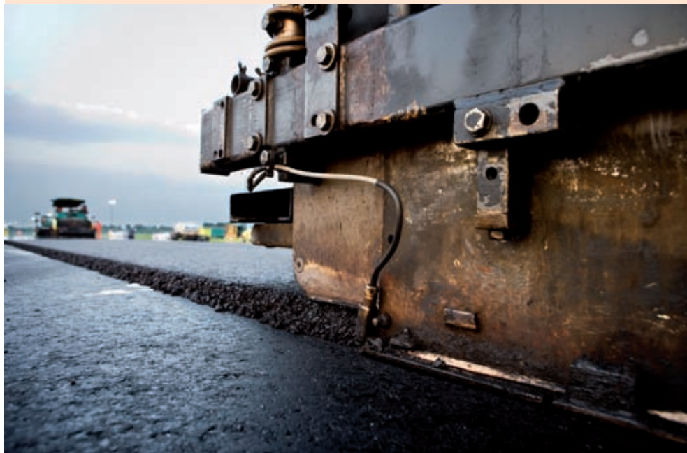
Vijf centimeter van een speciale asfalt deklaag
